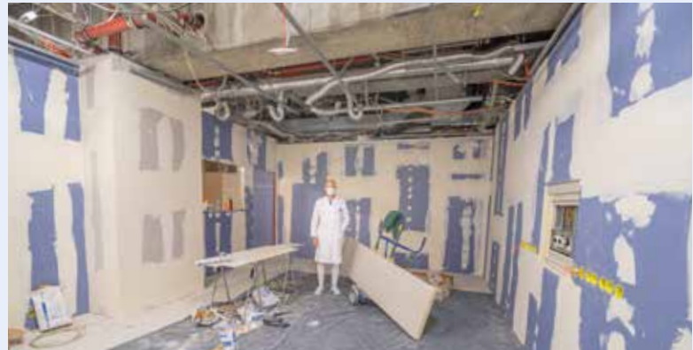
Für das neue Angiografiegerät mussten Räume komplett umgebaut, mit Strom- und Datenleitungen sowie Lüftungsschläuchen versehen werden. Hier Professor Zähringer auf der Baustelle Mitte September
