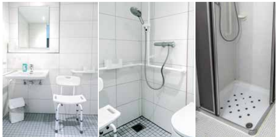
l. u. M.: Die neuen barrierefreien Bäder. r.: Bisherige Dusche mit Umrandung
