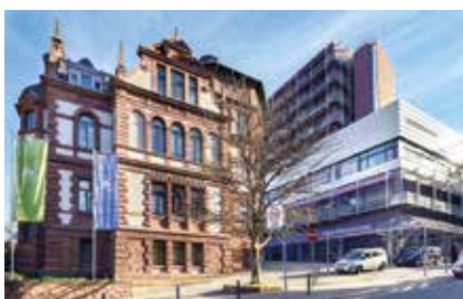
Alt- und Neubau des Krankenhauses
