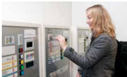
Kassenautomat in der Eingangshalle
