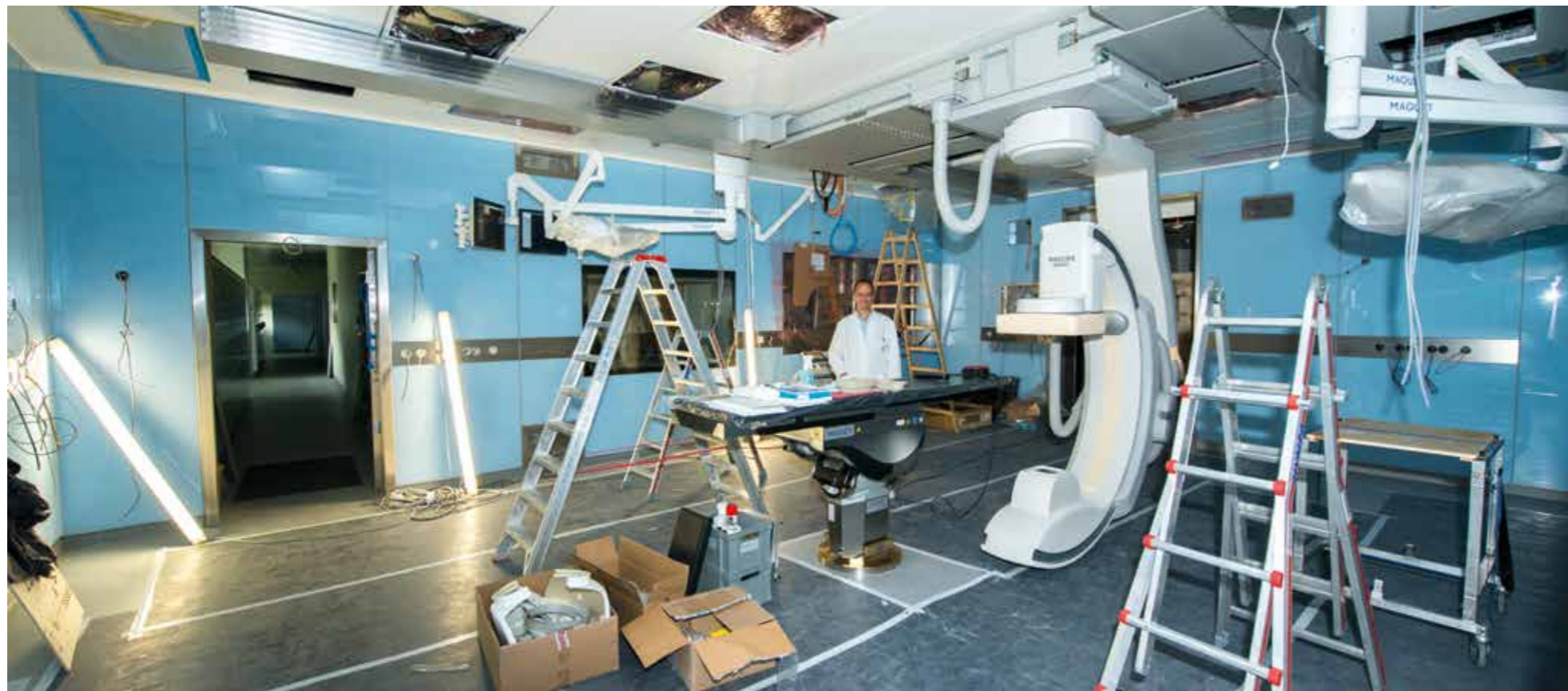
Dr. Klaus Klemm auf der Baustelle des neuen Hybrid-OPs, von dem Patienten der von ihm geleiteten Klinik für Gefäßchirurgie profitieren werden. An der Decke hängend rechts neben dem OP-Tisch ist bereits der fernsteuerbare C-Bogen montiert
