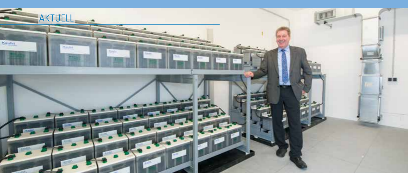
Joachim Pongratz im Batterieraum. Fällt der Strom aus, übernehmen zunächst Batterien die Notstromversorgung
