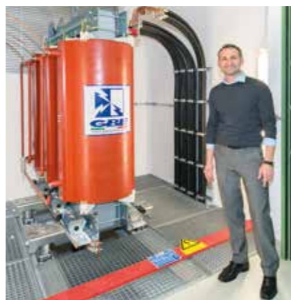
Rainer Friedmann vor einer von sieben neuen Trafoanlagen. Hier wird der ins Haus kommende Strom von 10 000 auf 400 Volt heruntergeregelt
