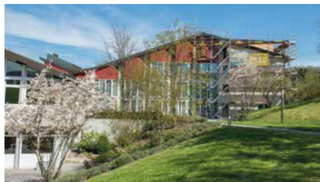
Damit die neuen Zimmer keine störenden Dachschrägen haben, wurde das Dach angehoben (rechts im Bild)
