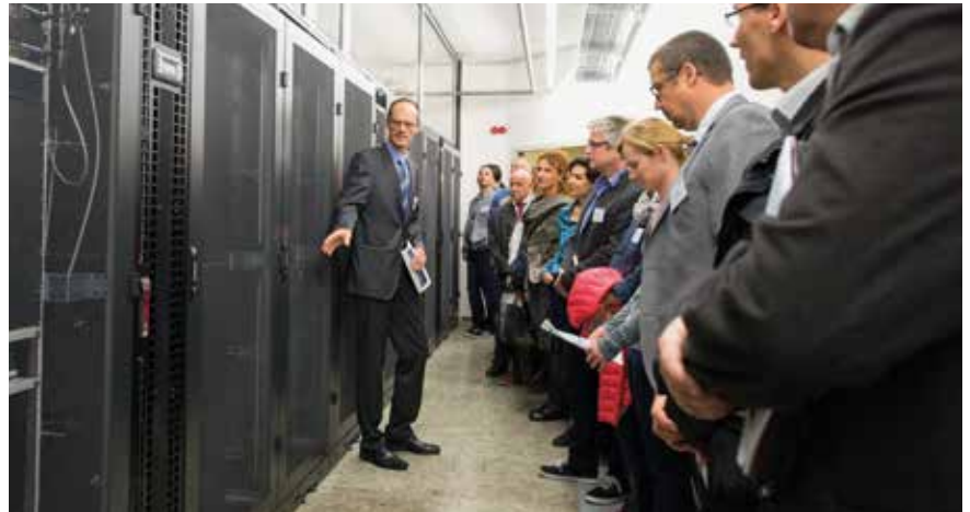
IT-Abteilungsleiter Stephan Rühle zeigt den Gästen das neue Rechenzentrum
