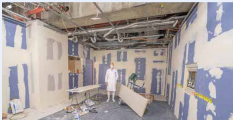
Für das neue Angiografiegerät mussten Räume komplett umgebaut, mit Strom- und Datenleitungen sowie Lüftungsschläuchen versehen werden. Hier Professor Zähringer auf der Baustelle Mitte September
