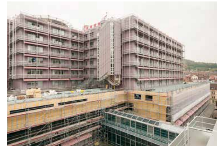
Auf einem ehemaligen Flachdach des Hauptgebäudes wird daher eine neue, deutlich vergrößerte Intensivstation gebaut.
