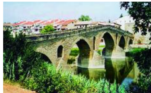
Puente la Reina – die berühmteste Brücke am Jakobsweg (Camino)
