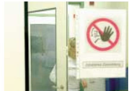
Zwei von drei Türen müssen in der Schleuse immer geschlossen sein
