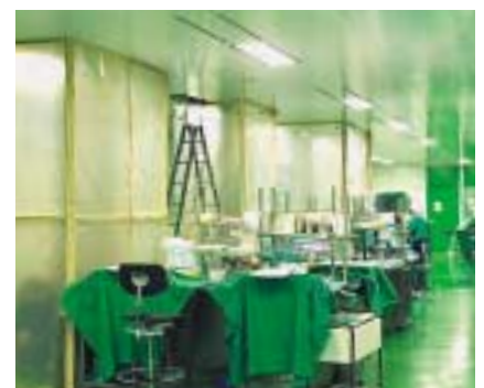
Trotz Umbaumaßnahmen wurde in Steri und OP weitergearbeitet
