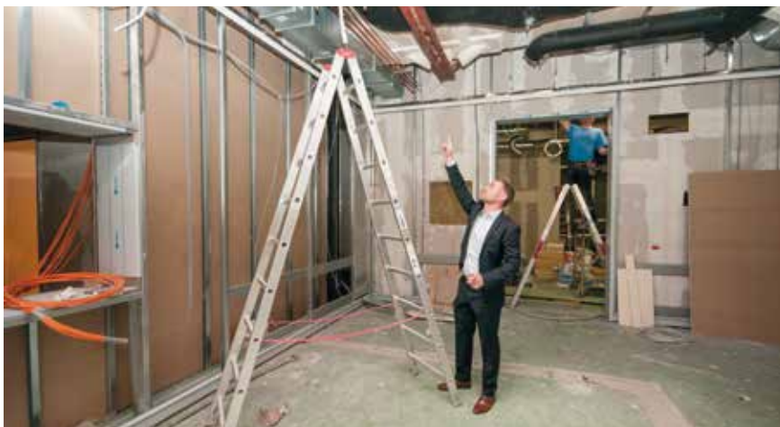
Rainer Friedmann, Chef der klinikeigenen Bauabteilung, auf der OP-Baustelle
